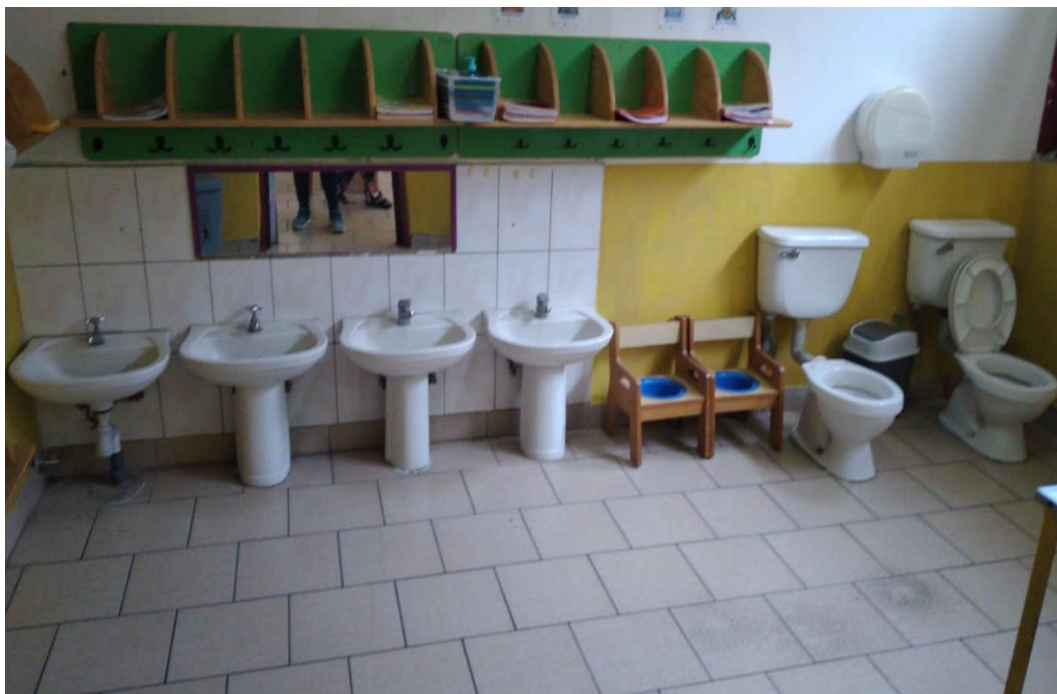
Ilustración 38 Área Intervención 1: mejoramiento y reposición servicios higiénicos y sala de mudas. (Antes del Proyecto)
